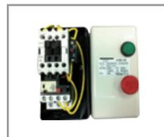
Incluye arrancador TECO HUEB-16K con breaker magnético, con protección de variación de carga y fuga eléctrica. (distancia máxima de instalación 100m)
